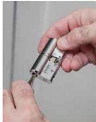
**3 Introduzca el nuevo cilindro sin forzar ni recurrir al martillo.** Inserte la llave completamente en el nuevo cilindro, gire un poco la llave hasta que la leva esté alineada con el cuerpo del cilindro e instálelo en su sitio, por la parte interior de la puerta. Nunca use el martillo para forzar la entrada. Puede dañarlo o dañar la cerradura.
