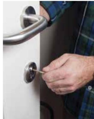
**4 Y vuelva a atornillar.** Asegúrese de que no haya suciedad que esté tapando el agujero del tornillo. Introdúzcalo y apriete con un destornillador manual, nunca con uno eléctrico, para no forzar el cilindro. No cierre la puerta sin comprobar antes que el cilindro gira con la llave puesta. Y valore la posibilidad de cambiar el escudo exterior por uno más seguro.
