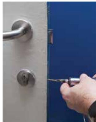
**1 Desatornille por el filo de la puerta.** Esta operación se debe realizar con la puerta abierta. Afloje el tornillo del cilindro viejo en el lateral de la puerta y retírelo por completo. Normalmente no hace falta quitar el embellecedor de la cerradura, ni el exterior ni el interior.
