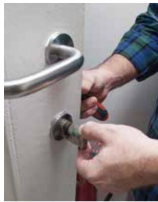
**2 Extraiga el cilindro hacia dentro.** Inserte la llave y gire ligeramente para alinear la leva (una pieza que sobresale en la zona central del cilindro) con el cilindro, hasta que el bloque salga sin esfuerzo. El desencaje debe hacerse con suavidad por el lado de dentro de la puerta, sin ejercer presión. Luego vaya a la tienda y compruebe que el nuevo cilindro tiene la misma medida.
